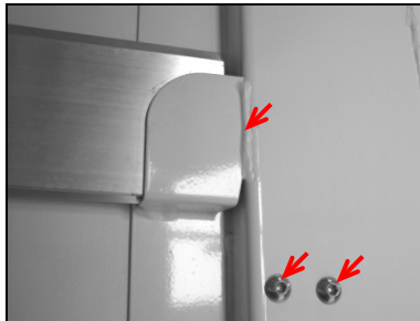
Выемка для закладки детали на угловой стойке
